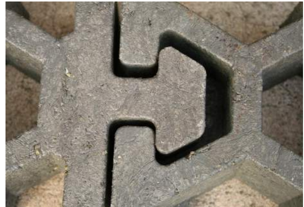
Hakenverbindung der Kraiburg-Gitterbodenplatten als Unterbau
